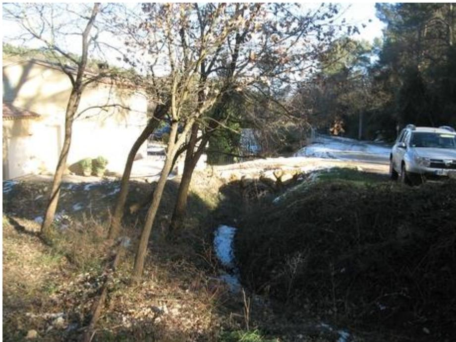
**Photographie 4 : Habitation récente rendue vulnérable par la présence d'une digue transversale qui reporte la dynamique des écoulements en rive gauche.**
