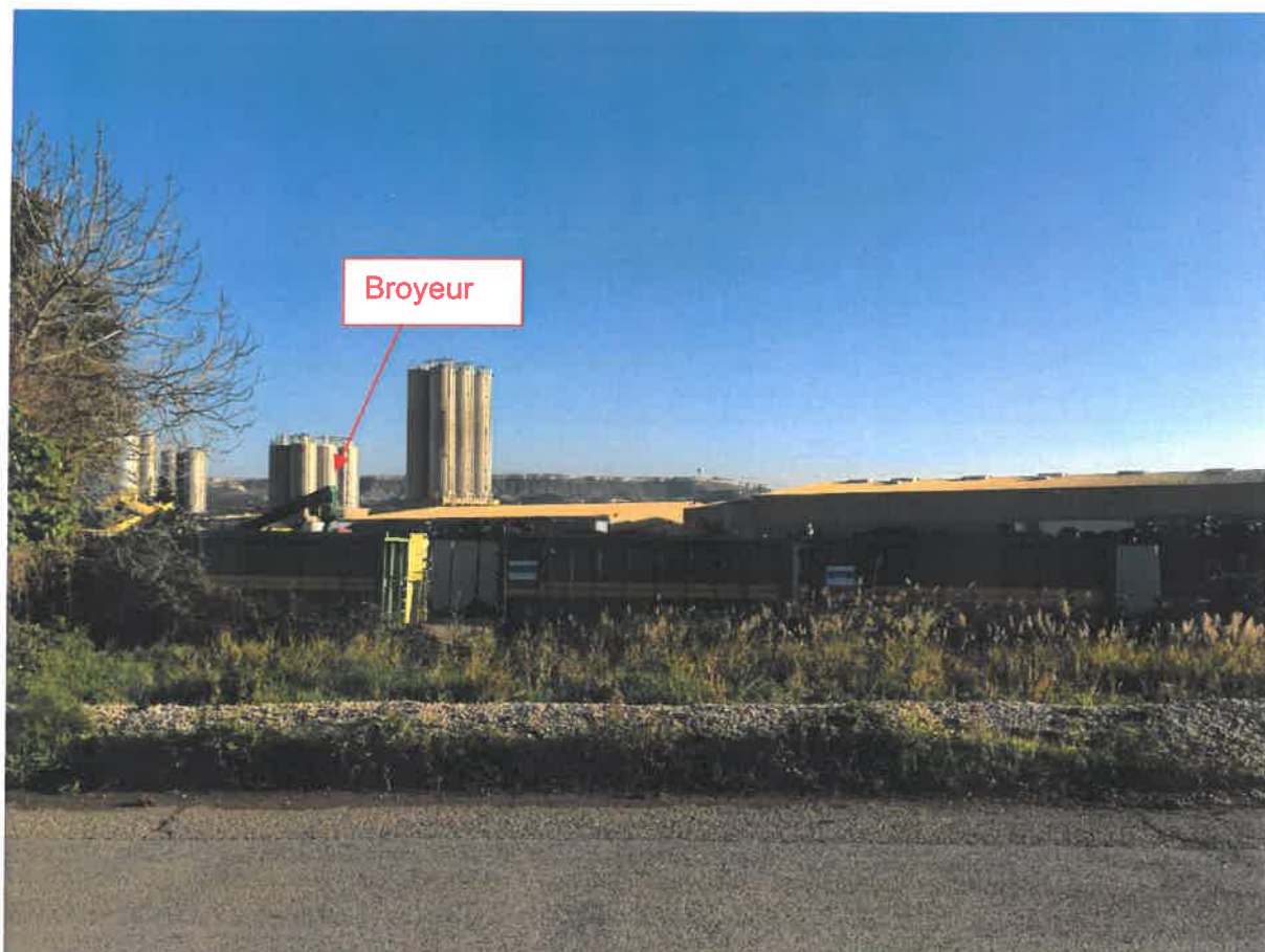
Vue Nord-Sud au niveau de l'accès Nord-Ouest du site – Date : 06/12/2019
