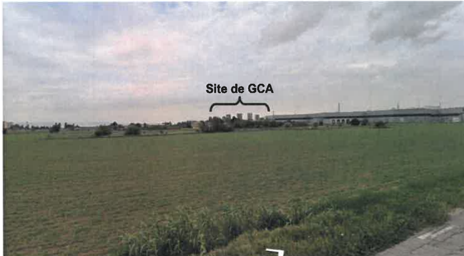
Vue n°3 de l'avenue Clément Ader au Nord-Est du site
