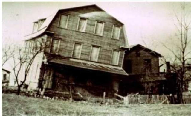
*Dommage sur une habitation en raison de la survenance d'un affaissement – (source : © GEODERIS)*
