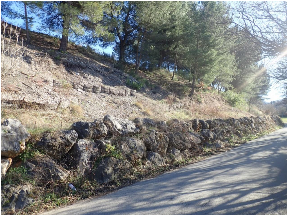
Terril Saint-Pierre (V137) – Enrochement de soutènement du pied Ouest
