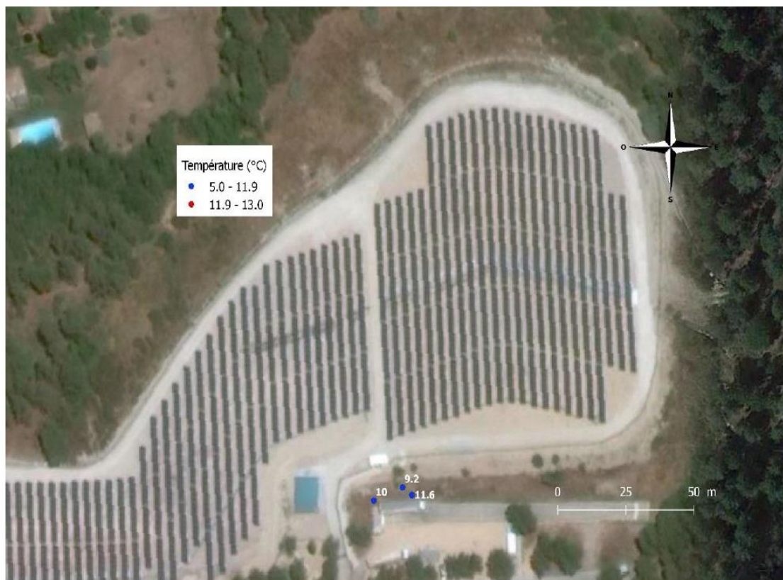
Températures relevées au sol en 2017 au niveau des zones d'échauffement repérées en 2014 sur le terril de Madame d'Andrée (source BRGM / DPSM, cf. [10])
