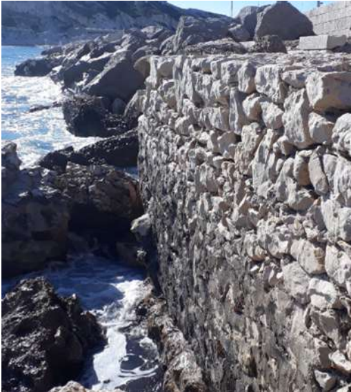
FIGURE 9 : FONDATION DE LA RISBERME
