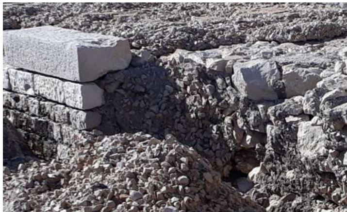
FIGURE 7 - RISBERME : VUE DU PAREMENT MAÇONNE ET DU REMBLAI
