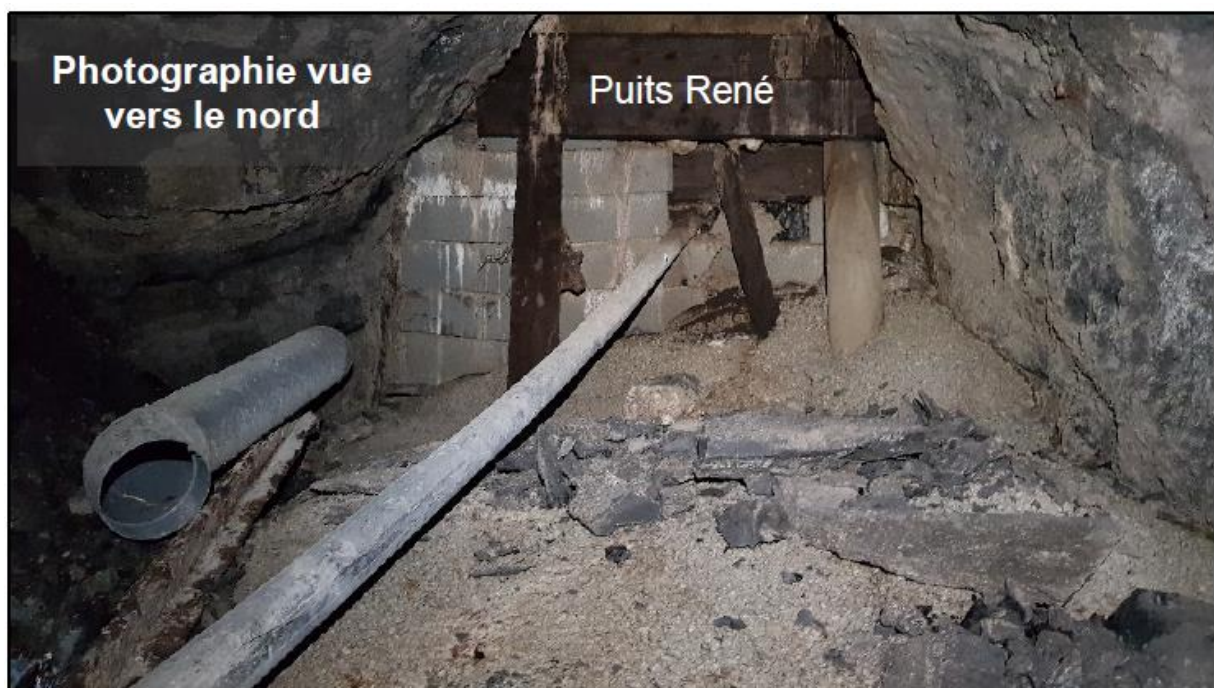
Figure 6 : Vue du mur en parpaings à la jonction du TB et du puits René (cf. [3])
