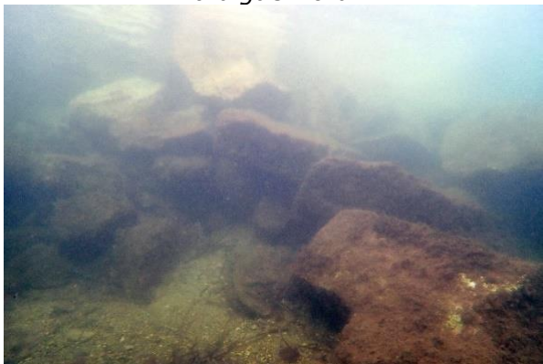
Les enrochements en pied de la digue Nord
