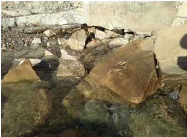
La zone affouillée sous la digue (zone 1)
