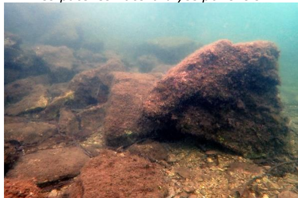
Les enrochements en pied de la digue Nord
