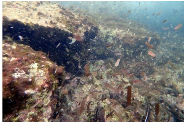
La pied de la digue Est
