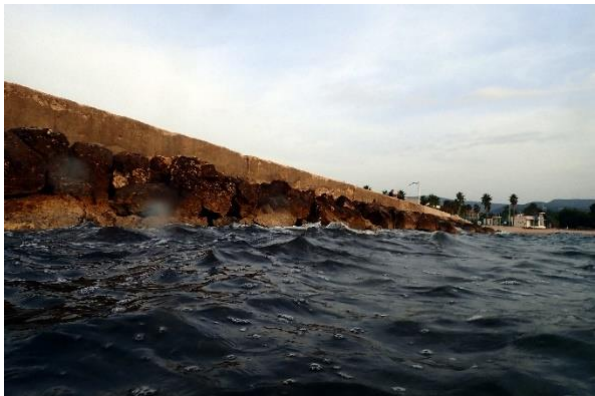
La digue Est
