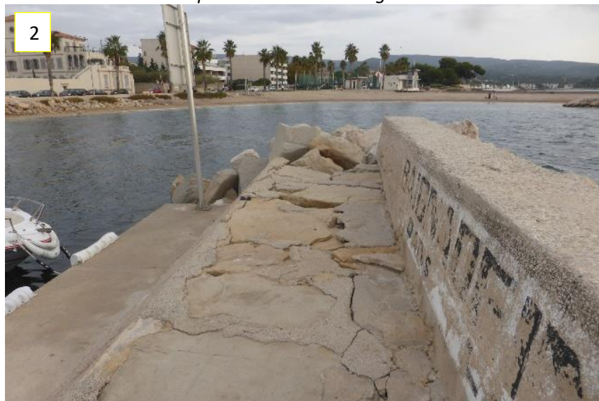
Le musoir de la digue Est
