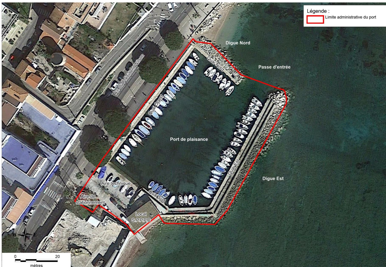
Description de l'espace portuaire
