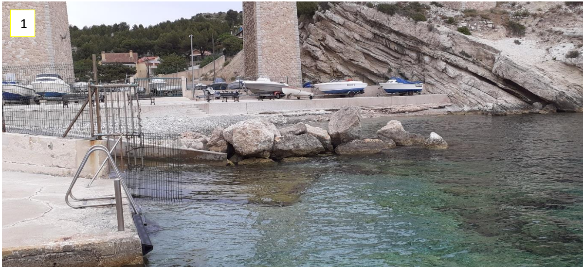
L'épi de protection à restructurer
