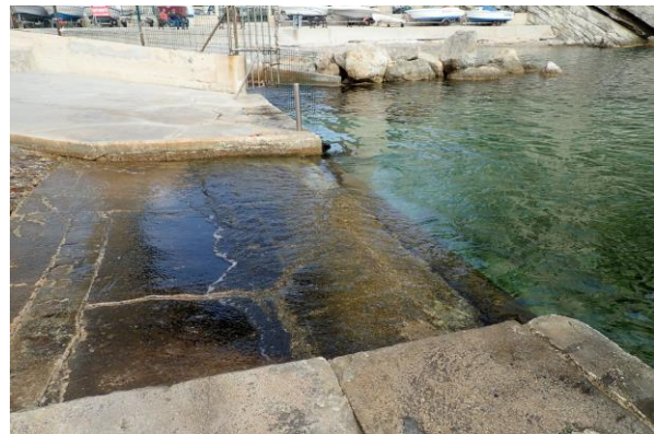
La partie du quai à rehausser
