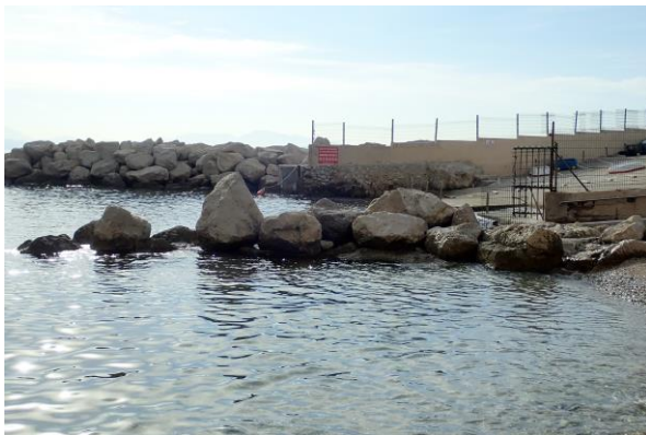
L'épi de protection de la cale de mise à l'eau détruit
