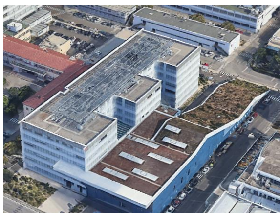
Photo satellite du bâtiment F3
