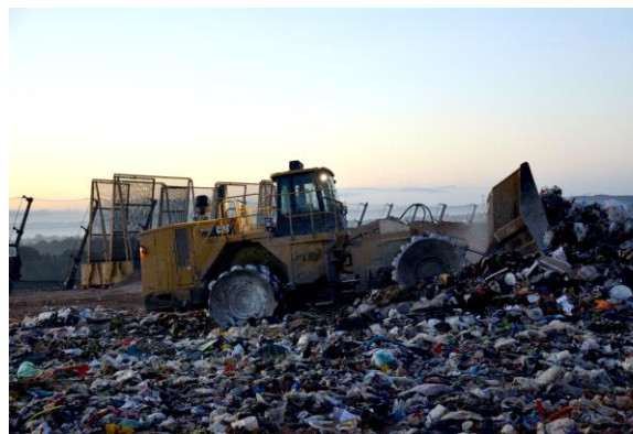
Compacteur procédant à l'étalement des déchets
