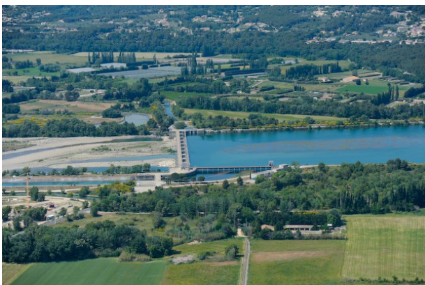
Barrage de Mallemort
