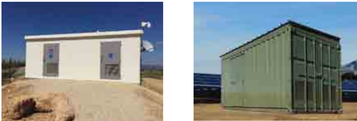
Exemple de poste de livraison et de local d'exploitation
