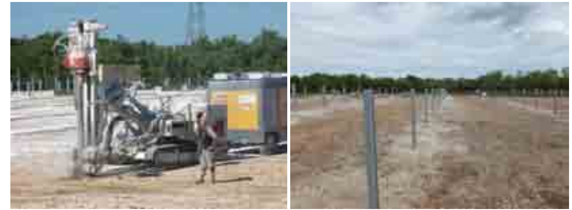
Mise en place des pieux
