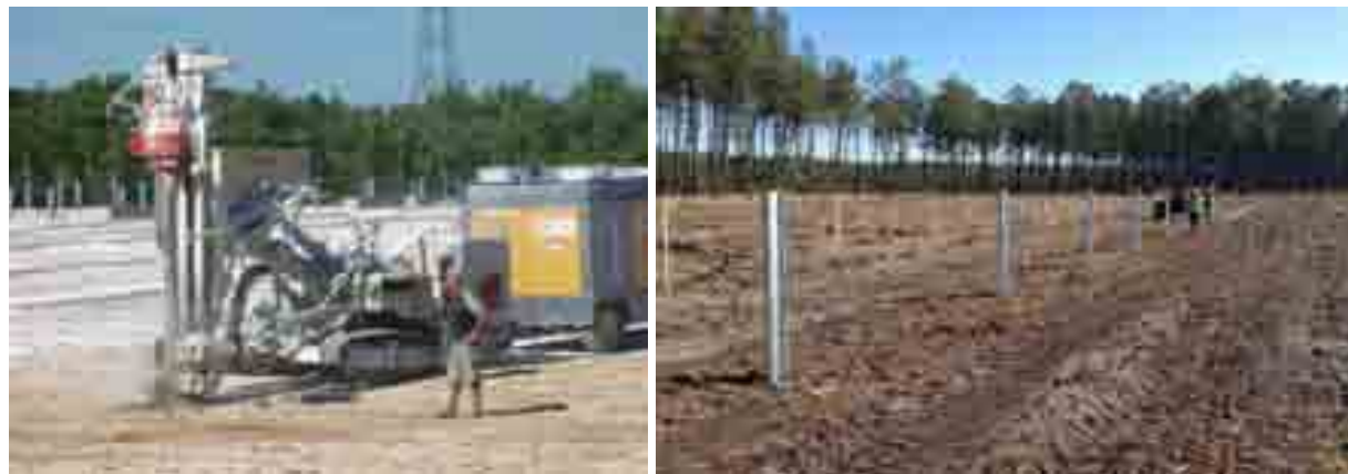
Illustration 9 : ancrage au sol par pieux battus
