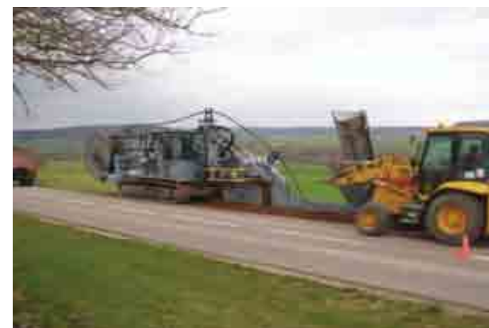
Trancheuse et raccordement
