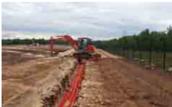
Construction du réseau électrique
