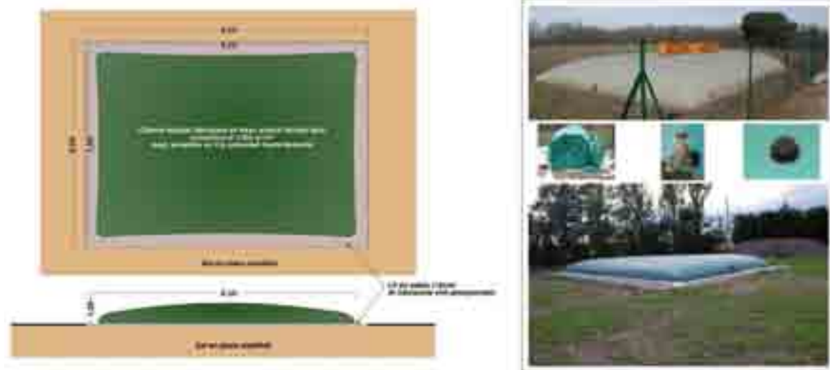
Illustration 12 : Type de citerne souple installée (système de lutte contre les incendies)
