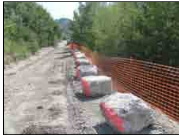
Exemple de mise en place d'un balisage de stations d'espèce protégée et d'un dispositif prévenant contre la sortie accidentel d'engins de la zone d'emprise
