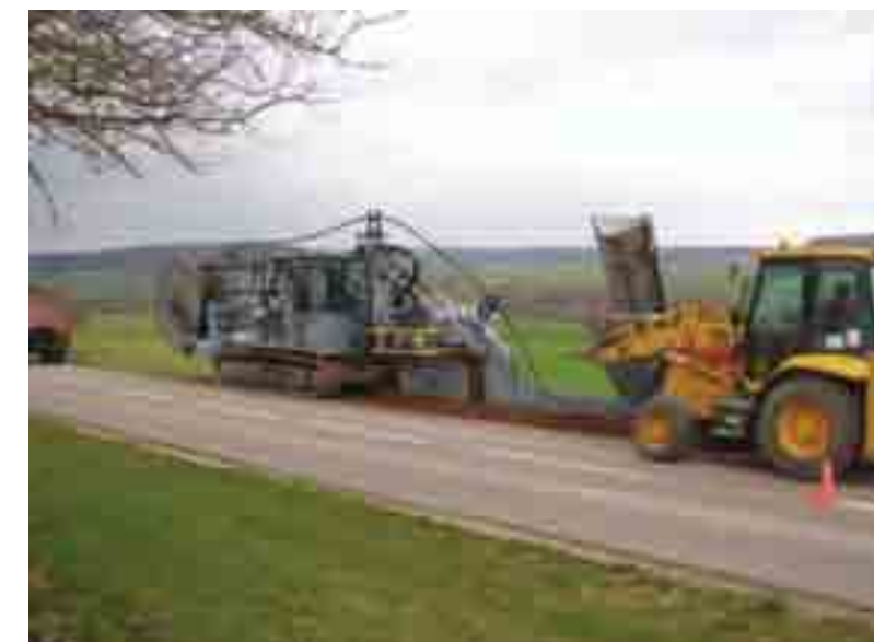
Trancheuse et raccordement
