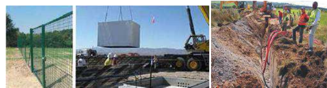
Illustration 20 : Exemple de chantier d'un parc photovoltaïque
