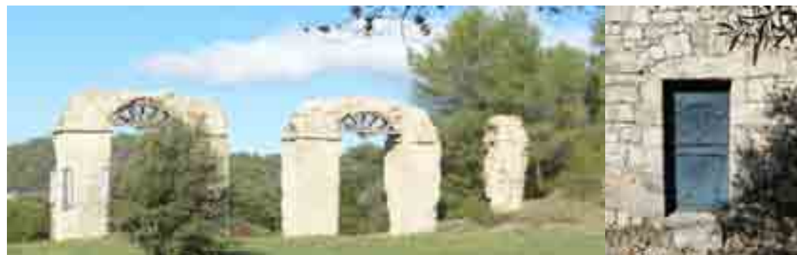
Aqueduc romain de la Traconnade (à gauche) et la Chapelle (à droite) (© Cabinet ECTARE)
