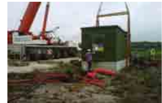
Exemple de transport d'un poste de livraison
