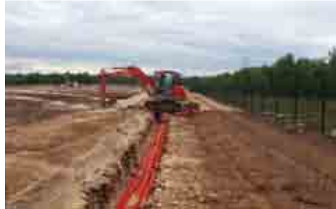
Construction du réseau électrique
