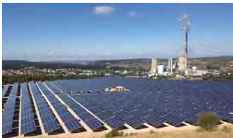
Réalisations Urbasolar : en haut, Granitec en Bulgarie. En bas, aménagement d'un ancien terroir à Gardanne (13)
