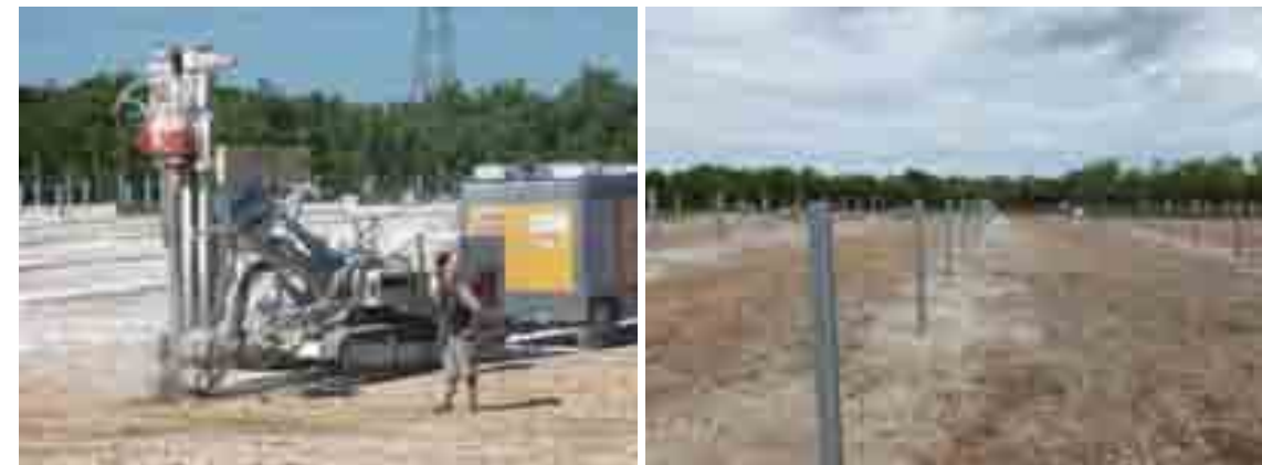
Mise en place des pieux
