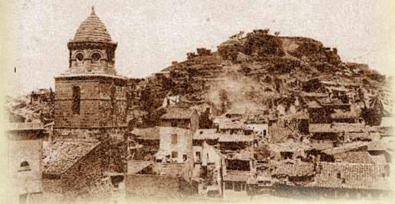
TREMBLEMENT DE TERRE des (B.-du-Rh.) 21 Juin 1909. 8. ROGNES - Vue Générale, côté ouest tout effondré, au centre une Maison s'écroule
