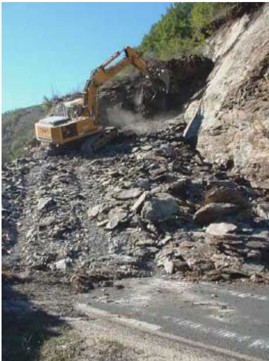
Élimination des masses instables et des masses éboulées (Purge, Abattage, Reprofilage) © CETE Méditerranée - Journée technique « Risque Rocheux »
