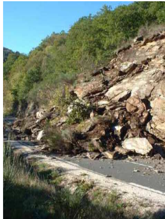
Élimination des masses instables et des masses éboulées (Purge, Abattage, Reprofilage) © CETE Méditerranée - Journée technique « Risque Rocheux »
