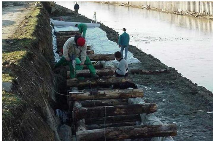
Figure 79 : mise en œuvre de caissons végétalisés.
