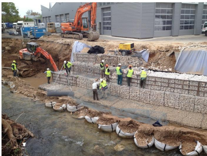
Figure 64 : Exemple de batardeau – SI du ruisseau de la Cadière 2013 – Moe : SCE
