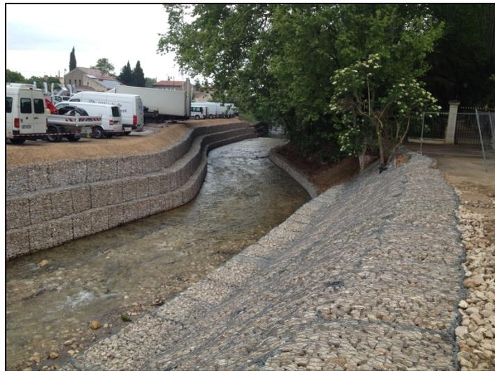
Figure 77 : Réalisation de protection en gabions – SI du ruisseau de la Cadière 2013 – Moe : SCE
