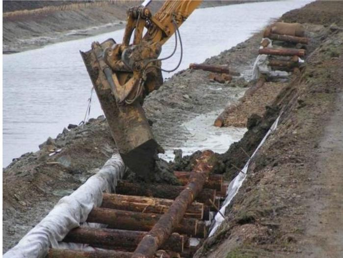
Figure 80 : mise en œuvre de caissons végétalisés.
