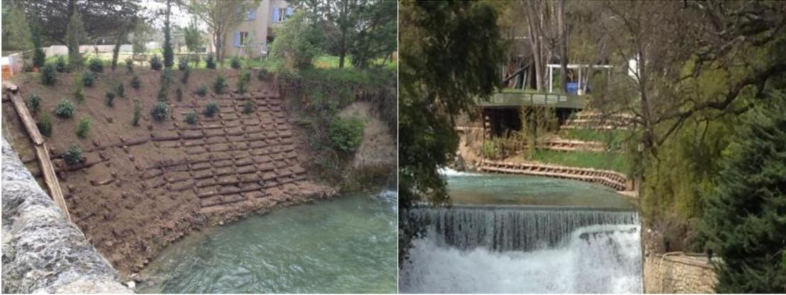
**Figure 6 : Réalisation de caissons végétalisés – SIA Nartuby 2013**
