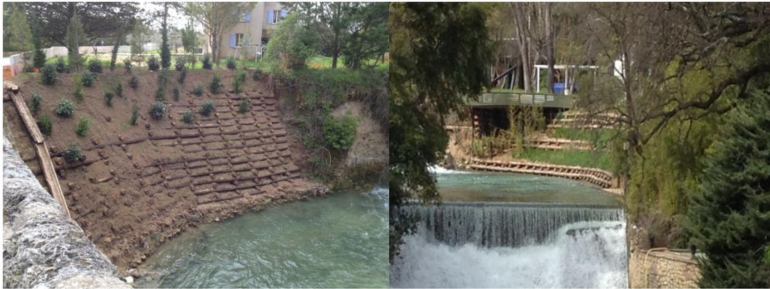
Figure 78 : Réalisation de caissons végétalisés – SIA Nartuby 2013
