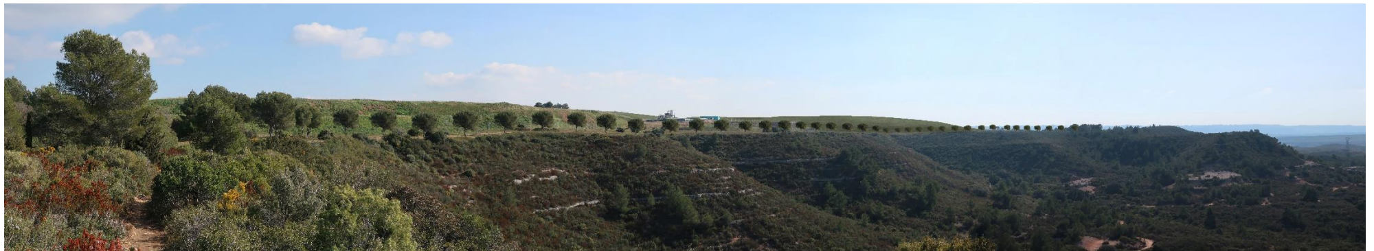
Figure 13 : Insertion paysagère du projet d'extension de l'ISDnD de l'Arbois avec mesures d'intégration paysagère– axe Nord, source Thomas ALEGRE
