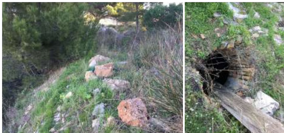
Partie supérieure de la voute
