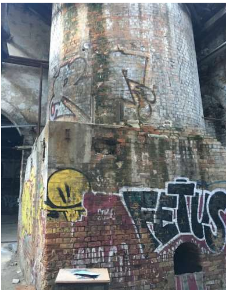
Pied de la cheminée
