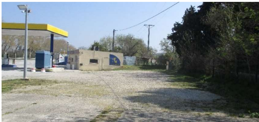
Figure 18 : Secteur à privilégier pour l'installation de la zone de stockage et la base de vie
