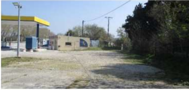
Figure 10 : Secteur à privilégier pour l'installation de la zone de stockage et la base de vie
