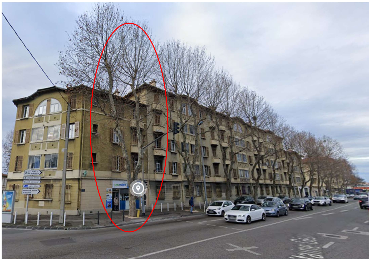
Figure 6 - un platane supprimé au niveau du carrefour Casanova (source googlestreet view)
