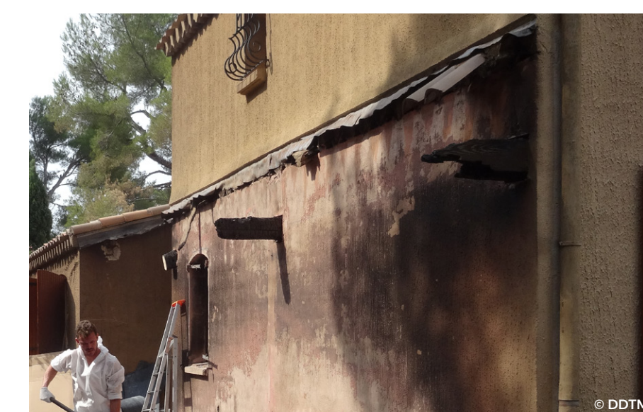
Pas de poutre apparente extérieure
