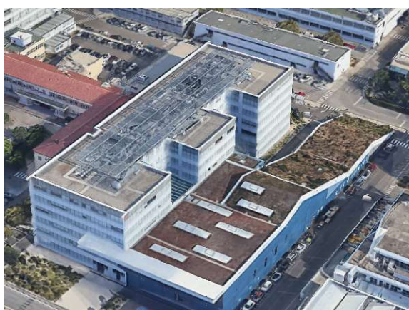
Photo satellite du bâtiment F3
