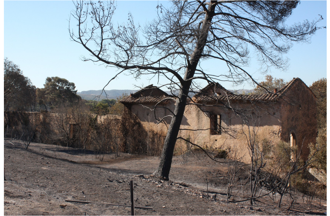
Incendie du 10 août 2016
