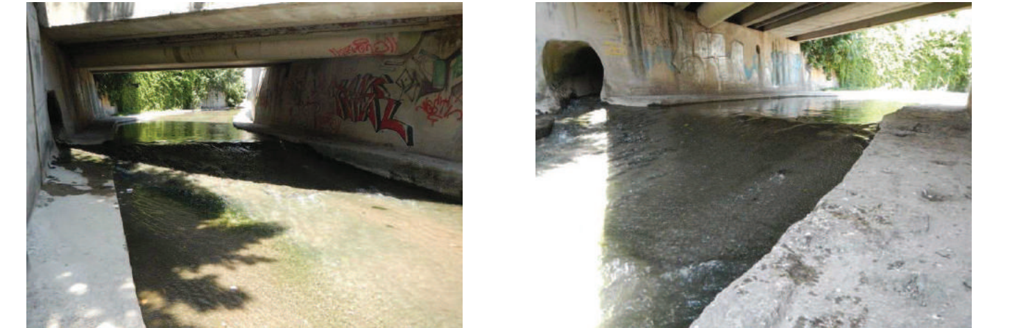
Photographies de l'ouvrage prise au cours de la prospection
