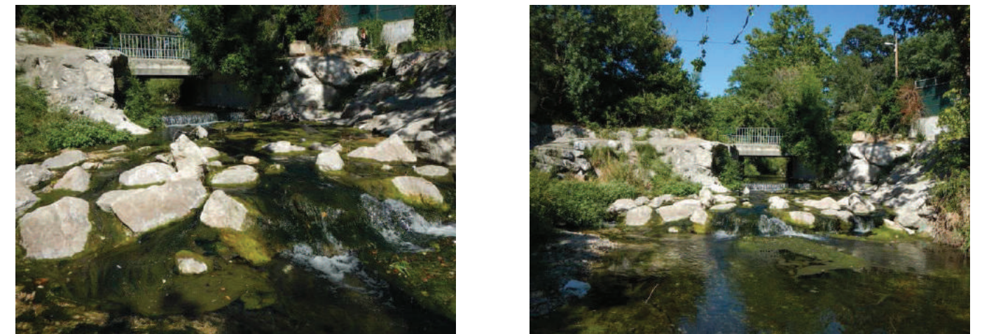
Photographies de l'ouvrage prise au cours de la prospection
