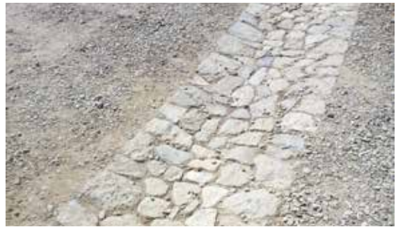
Un calepinage de pierres sert de caniveau.
