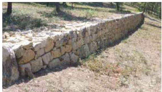
Une restanque en pierre sèche ralentit l'eau de ruissellement, utilise des matériaux locaux et favorise la biodiversité.
