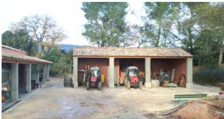
Ce hangar est dimensionné correctement pour abriter les engins agricoles (ici à Puyloubier).
