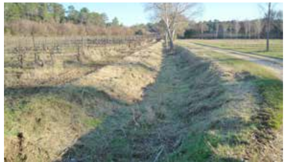
Une noue de récupération des eaux.
