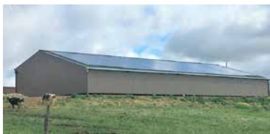
Sur cette exploitation, les panneaux photovoltaïques couvrent la totalité d'un pan de toiture.
