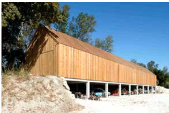
À Avignon (84), ce hangar utilise la topographie pour dissimuler le stockage des engins. [Unic Architecture]
