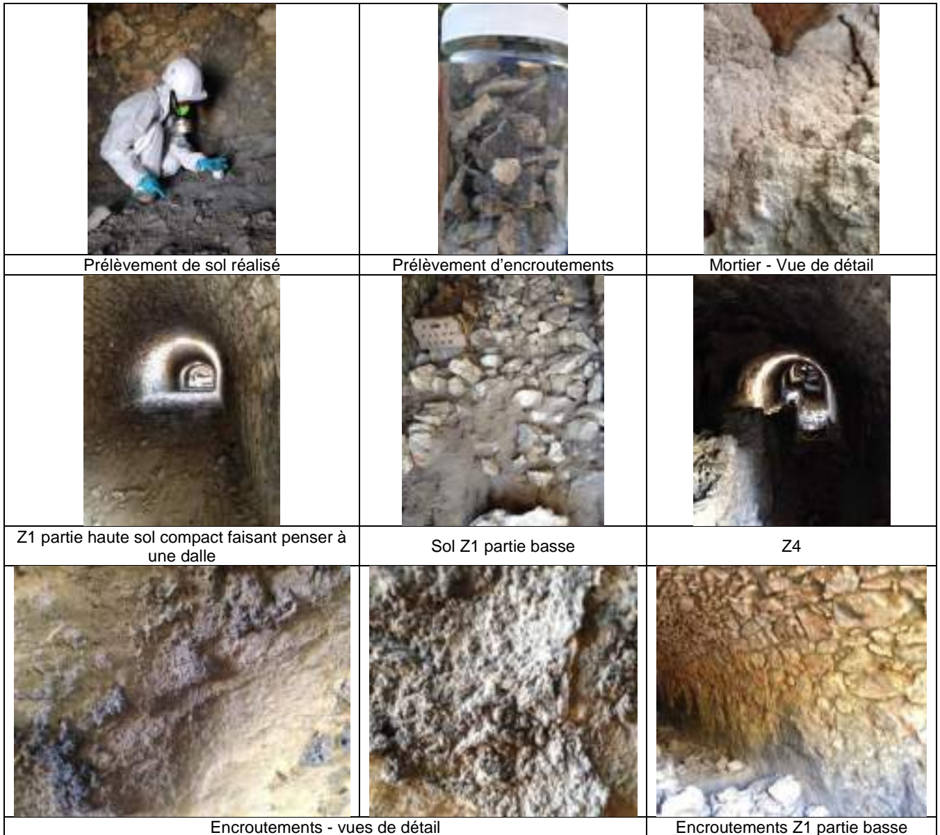
Figure 49: Reportage photographique des investigations réalisées - cheminée rampante
