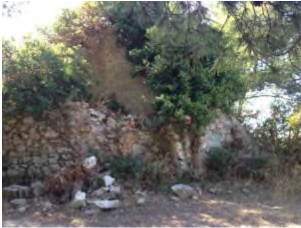
Figure 37 : Cheminée rampante partie nord avec assise en brique
