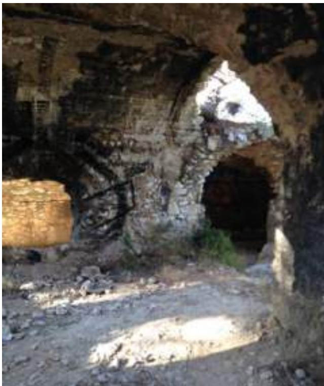
Figure 40 : Photographies des Carneaux haut en partie démolis et exposés aux vents et aux intempéries
