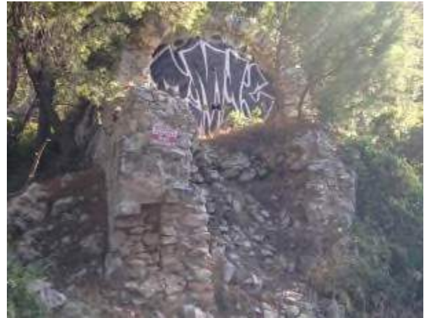
Figure 38 : Cheminée rampante partie sud constituée de deux niveaux
